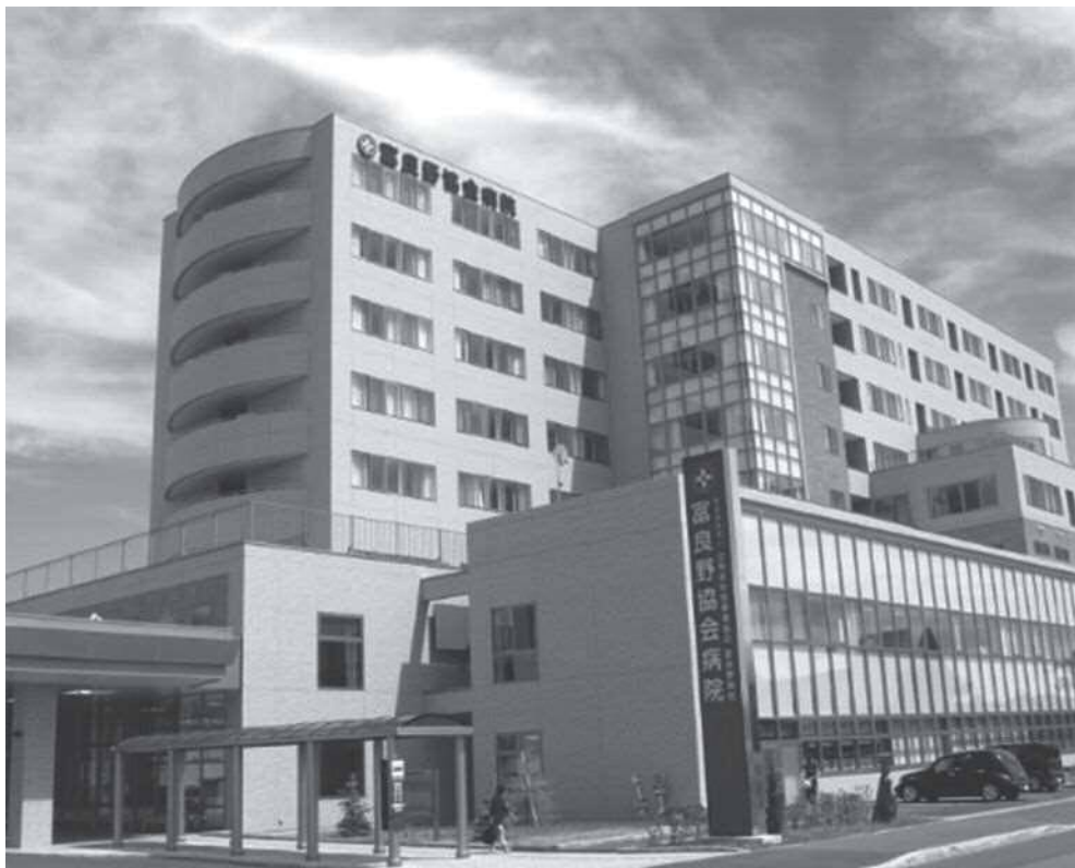
富良野協会病院 外観
